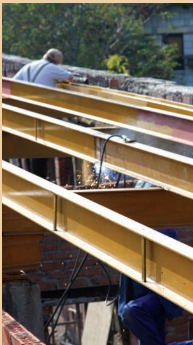
Praca na budowie posuwa się w szybkim tempie. Na zdjęciu robotnicy montują części konstrukcyjne remontowanego dachu.
