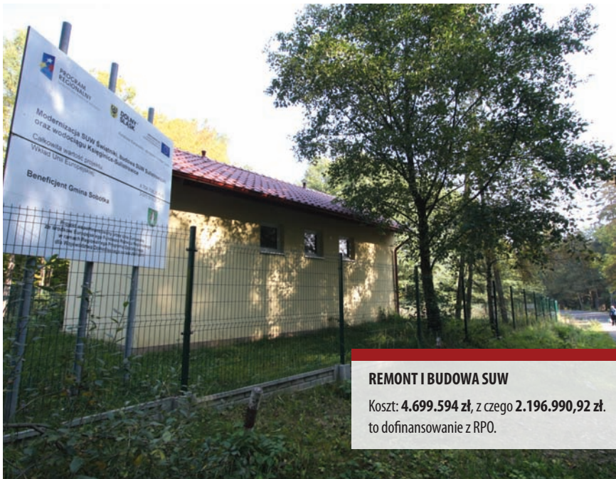
Stacja Uzdatniania Wody w Sulistrowiczach
