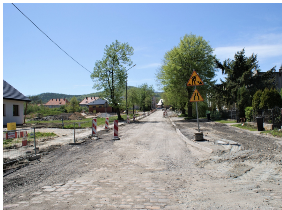
■ Prace na ul. Dworcowej w Sobótce
