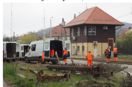
■ Trwa remont stacji w Sobótce Zachodniej
