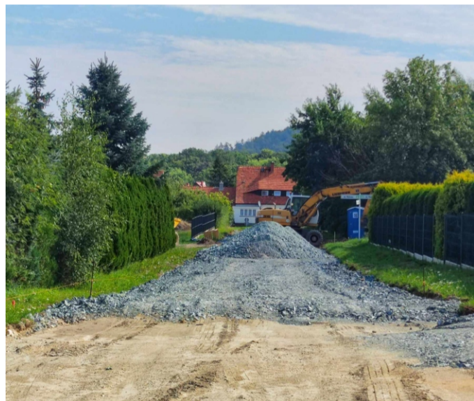
■ Sobótka ul. Chabrowa w trakcie wykonywania podbudowy
