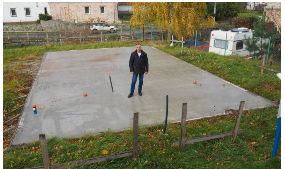
■ Miejsce na nową świetlicę. Już wylano fundamenty.
