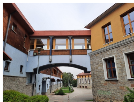
■ Wyremontowany dach łącznika oraz krawężniki w ZSP w Sobótce
